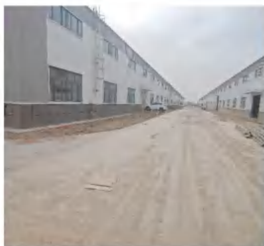
2#和 3#厂房及内部道路
