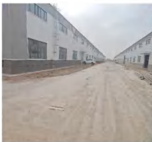
1#和 2#厂房及内部道路
