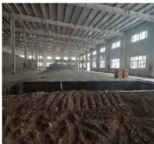
3#厂房污水处理设施 2
